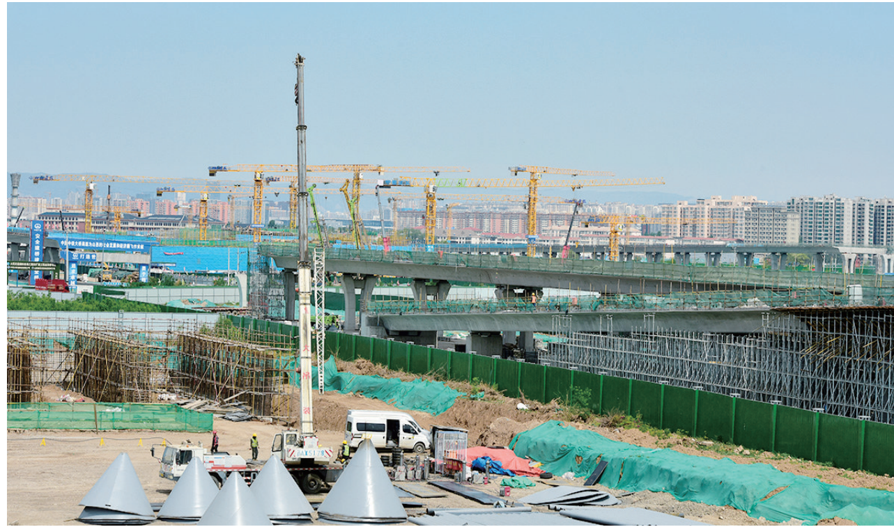
5月14日,太原武宿国际机场三期改扩建高架桥工程建设现场,桥梁已初具规模。该工程建成后,将串联T2航站楼、T3航站楼、综合交通中心,进一步改善机场交通。牛利敏 摄
