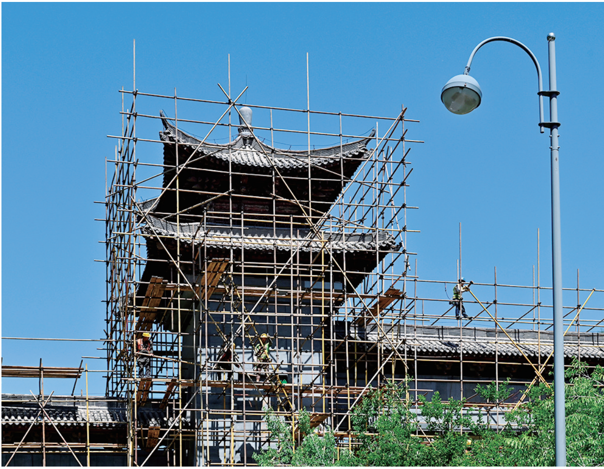
5月18日,市城管局市政建管中心施工人员在蒙山景区山门搭建脚手架。太原蒙山景区生态治理工程日前拉开序幕,本次建设内容包括土建工程、生态工程及亮化工程。工程完工后,蒙山生态系统将提升升级,更利于消除地质灾害隐患及防火安全隐患,进一步提升服务品质和游客体验满意度。梁琛摄
