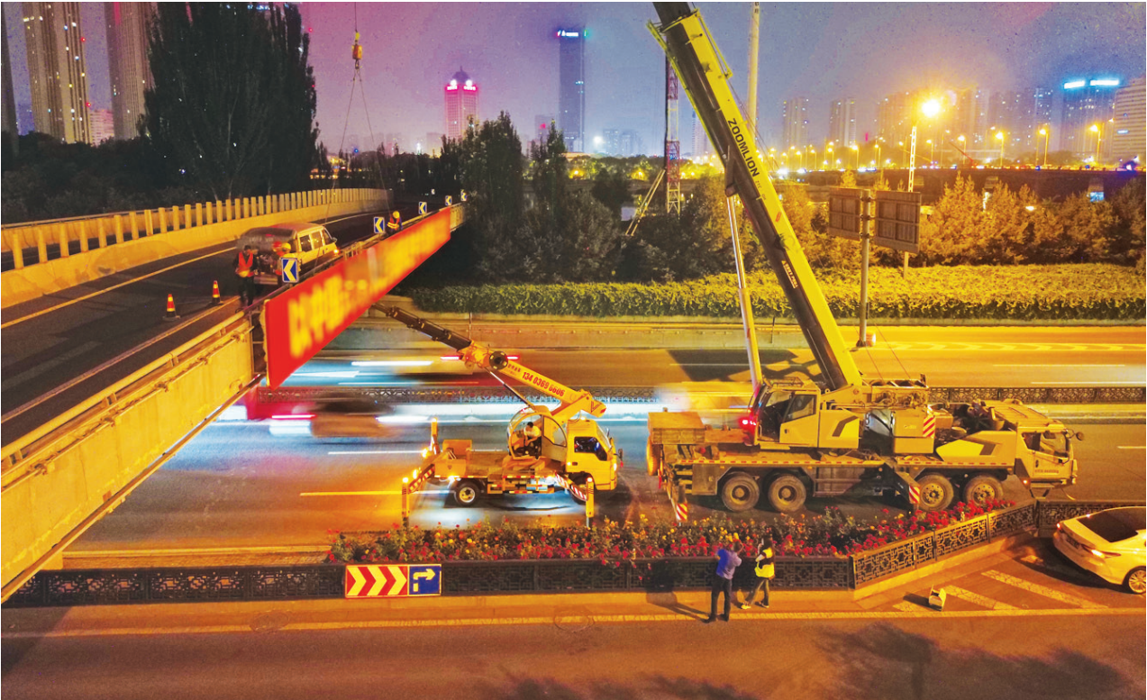
为做好迎泽大桥加固改造工程施工前期准备工作，5月19日23时，太原市市政建管中心桥梁管理所组织人员对迎泽大桥东南、东北、西南、西北匝道悬挂的7处宣传广告进行了集中拆除。牛利敏 杨斌 摄影报道
