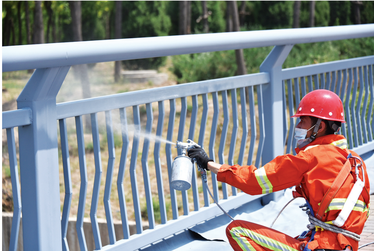
5月22日,太原市政建管中心的工作人员正在对滨河西路清水河桥、蚕石河桥、榆古路桥等8座桥梁栏杆进行喷涂作业,维护桥梁设施安全。 牛利敏 杨斌 摄影报道
