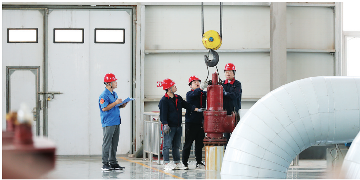
6月3日，太原市热力集团有限责任公司晋源供热分公司2号中继泵站工作人员在进行检验安全阀，提前为保障冬季供暖系统安全运行做好准备。
