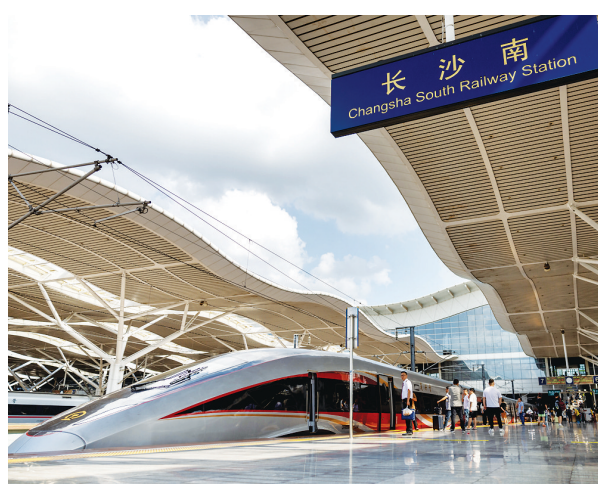
6月15日，武汉至深圳北的G875次列车经停长沙南站。京广高铁武广段复兴号动车组列车按时速350公里高标运营，标志着京广高铁武汉至广州段安全标准示范线全面建成。
