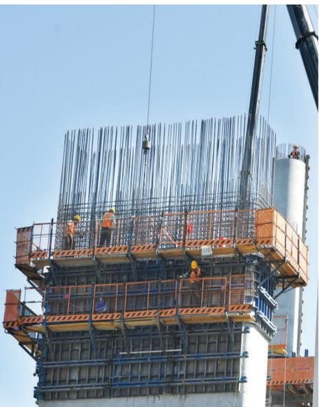
6月22日,青银二广高速公路太原联络线ZBLJ3项目工地,建设者们正在桥墩上捆绑钢筋,保障桥梁施工的有序推进。该项目是全省高速路网“四纵十五横三十三联”中的“寿阳南燕竹至迎泽区赵北峰”联络线,是山西省融入京津冀、对接环渤海的重要新通道。
