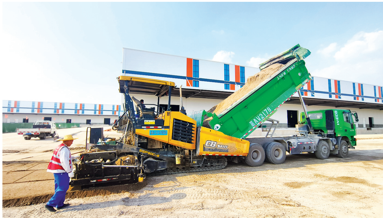
6月24日，杏花岭区杨家峪数字经济产业园智诚万家物流园项目，工人在铺设道路水稳层。该项目占地面积150余亩，总投资3.24亿元，功能集物流、仓储、办公为一体，建成后将实现电商、物流配送等环节有机结合，助力经济发展。
