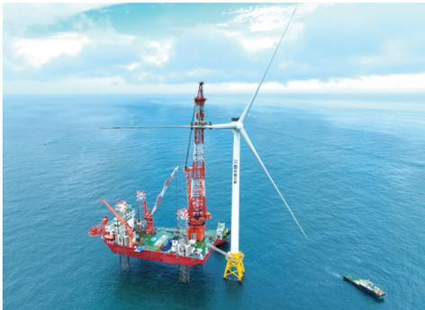
6月19日拍摄的三峡集团漳浦二期海上风电项目最后一台16兆瓦海上风电机组叶片安装现场(无人机照片)。6月27日，全国首个超大型单机容量的海上风电机组项目——三峡集团漳浦二期海上风电项目实现全容量并网发电。新华社记者 林善传 摄
