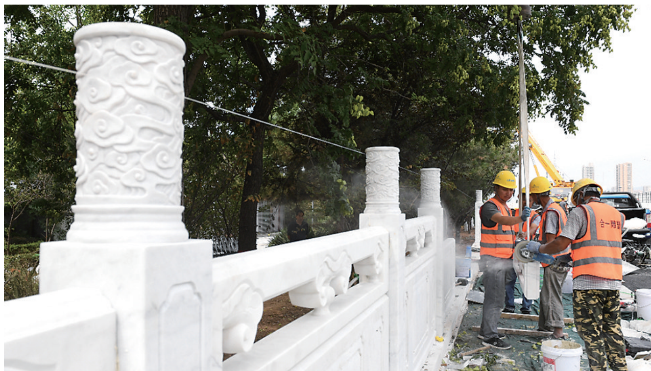
施工人员在安装汉白玉人行道护栏。牛利敏 摄
