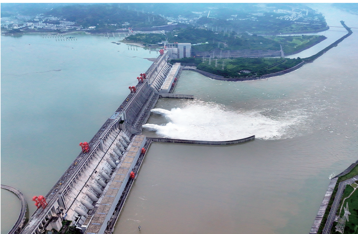
7月10日，长江三峡枢纽开闸泄洪深孔泄洪(无人机照片)。最新预报显示，长江上游未来一周将迎来多次涨水过程。为在洪峰来临前腾出防洪库容，水利部长江水利委员会调度三峡水库于7月10日14时、18时各开启1个泄洪孔，逐步将三峡水库出库流量由2.7万立方米每秒增至3.1万立方米每秒。这是三峡水库今年首次开闸泄洪。新华社发(王辉富 摄)
