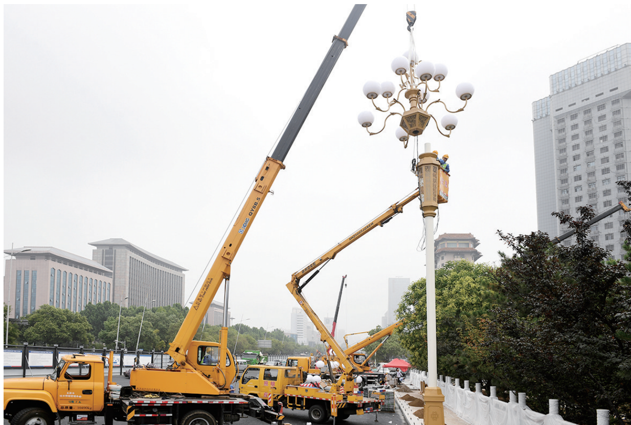
7月16日,迎泽大街维修改造工程首批路灯开始安装。
