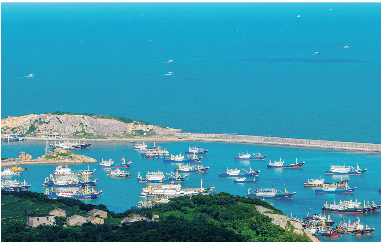
7月16日拍摄的浙江省温岭市石塘镇中心渔港(无人机照片)。近日，浙江省温岭市石塘镇各渔港内，休渔的渔船和各类船只有序停泊，时而有船只往来穿行，在蓝天、碧海的映衬下，构成一幅夏日渔港美丽画卷。
