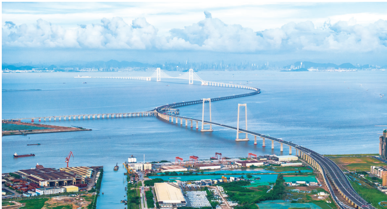
6月27日拍摄的深中通道全景。新华社记者 毛思倩 摄
