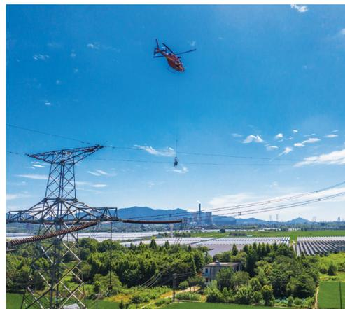
7月24日,在浙江湖州市长兴县吕胥线附近,一架直升机运送带电作业人员至超特高压线路检修点作业(无人机照片)。
