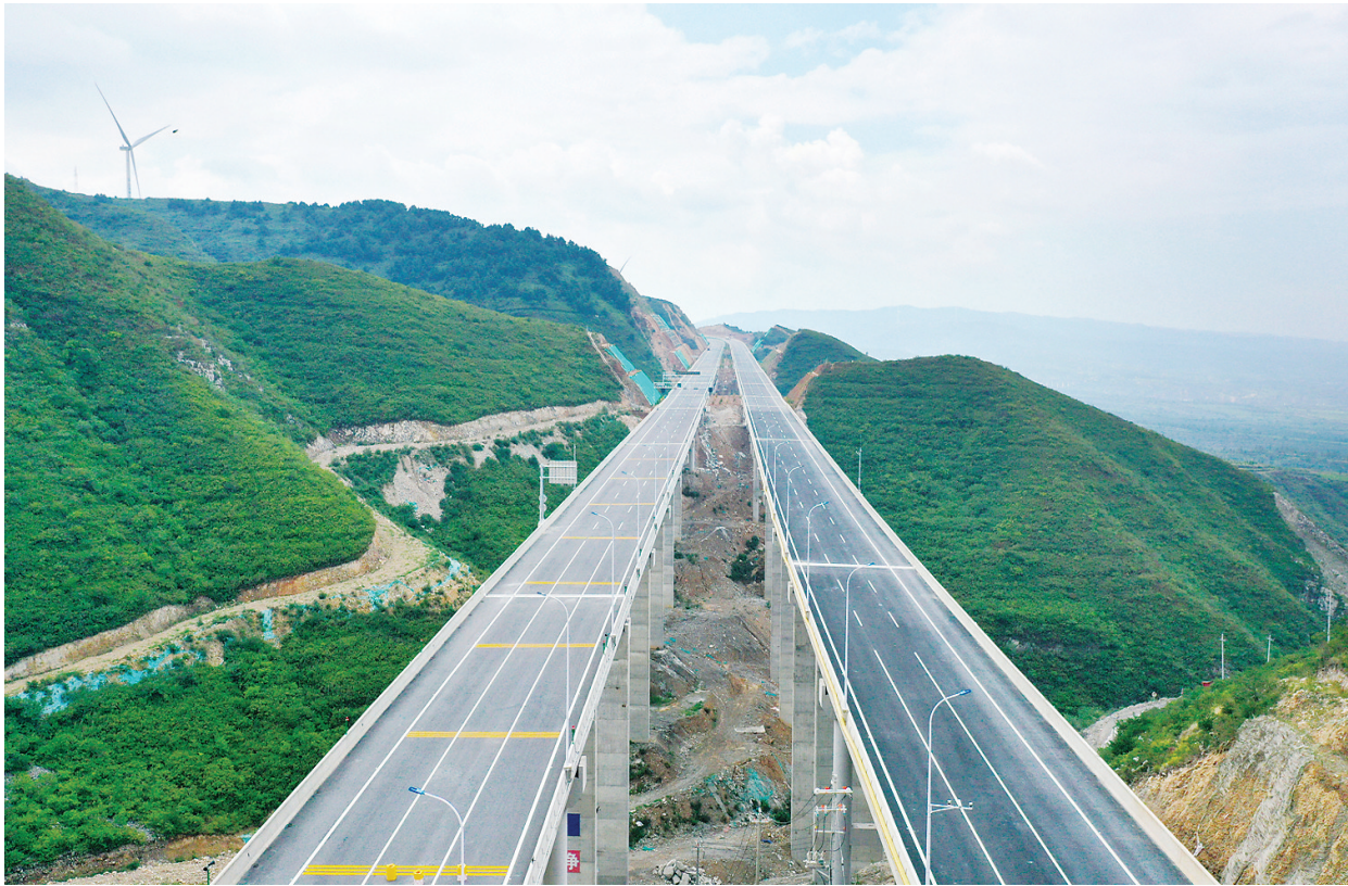
8月4日,太原西北二环高速公路东黄水段,交通标识划线完成。太原西北二环高速公路是国家和省重点工程,是我省“三纵十二横十二环”高速公路网的重要组成部分。韩双喜 李学军 摄影报道
