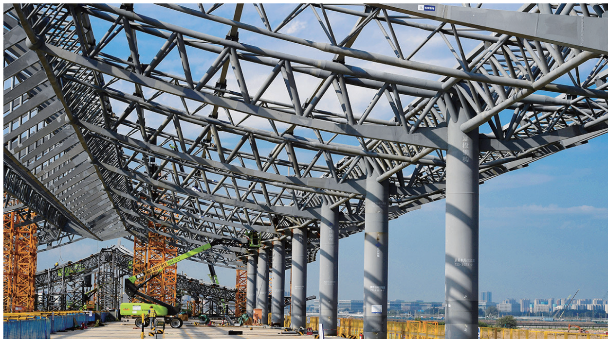
8月13日,太原武宿国际机场三期改扩建工程T3航站楼东指廊钢结构施工现场,工人正在利用吊车和自动升降平台车进行高空作业。 牛利敏 宋卫东 摄影报道
