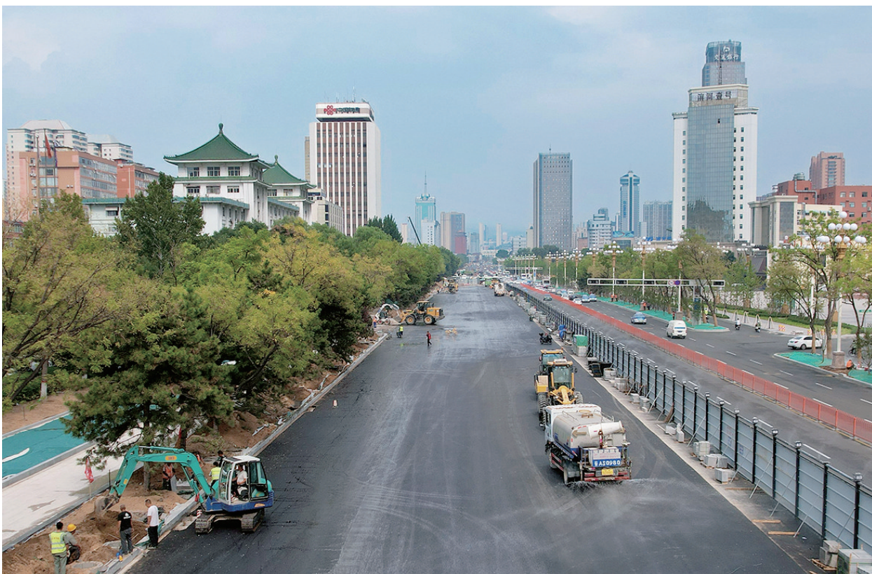
8月15日,迎泽大街维修改造工程解放路至新建路段北半幅进入到沥青铺设阶段。牛利敏 耿婧媛 摄影报道
