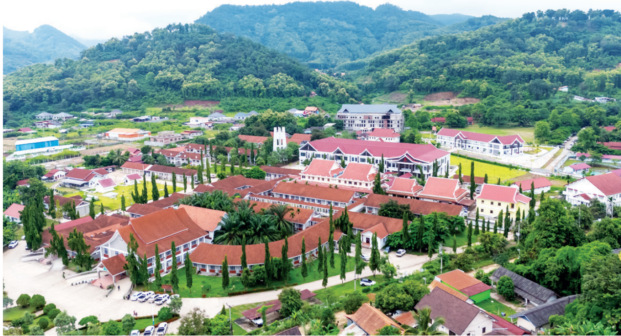
这是8月16日拍摄的老挝琅勃拉邦医院（无人机照片）。中国援老挝琅勃拉邦医院升级改造项目16日正式启用并移交老方。老挝卫生部、老中合作委员会以及中国驻老挝大使馆和项目建设单位等相关人员出席移交仪式。老挝琅勃拉邦医院由中国援建，本次升级改造项目包括新建外科和心血管科楼、中国专家公寓、污水处理站、消防水池和水泵房，维修改善此前援建建筑并提供相关设备。项目移交后中方还将开展为期三年技术援助，继续提升当地医疗卫生水平和医疗救治能力，把琅勃拉邦医院打造成为老挝北部地区的中心医院，切实改善当地民生。新华社发（凯乔摄）
