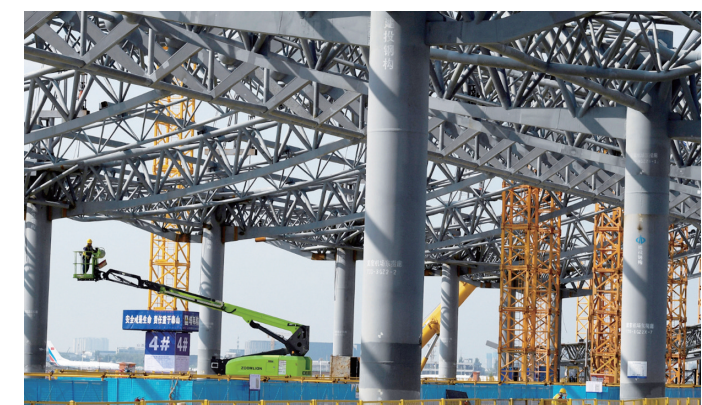
太原武宿国际机场三期改扩建工程利用新开发银行贷款,建设光储直柔零碳建筑、零碳能源中心等设施,建成后将成为国内首家零碳机场。 牛利敏 摄
