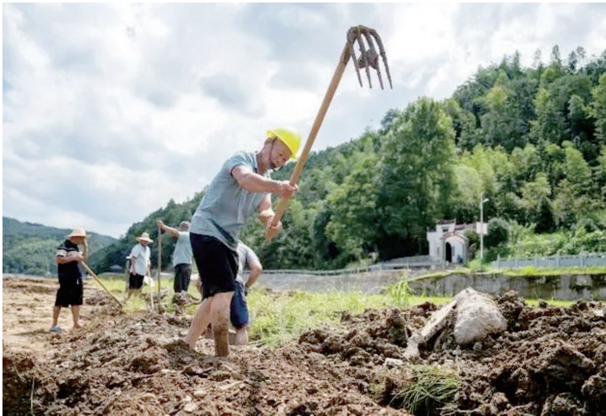
7月5日，在湖南省平江县加义镇周方村，村民在清理农田水渠里的淤泥。
