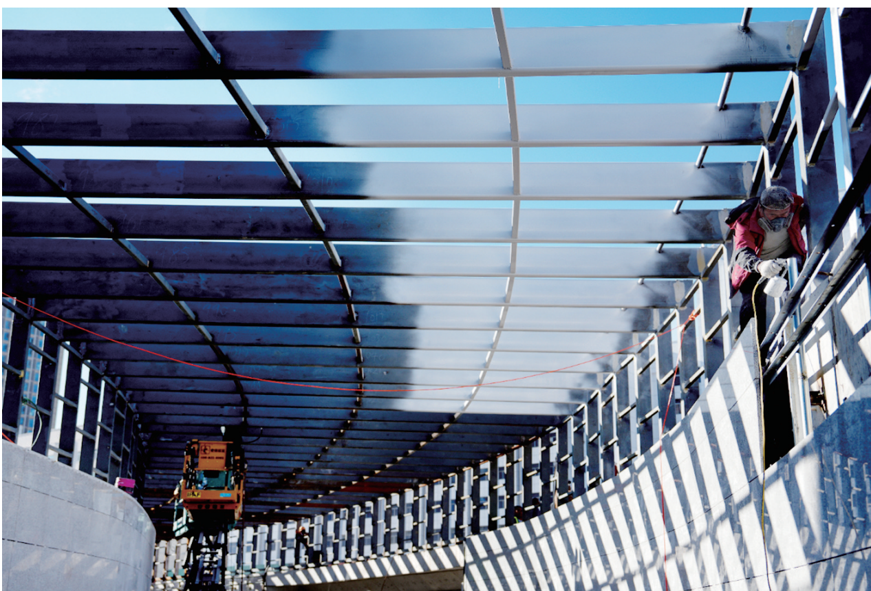
太原火车站区域改造是迎泽大街维修改造工程的重要节点之一。8月29日,施工人员正在对站前西广场地下通道进行改造,确保工程高质量推进,为市民创造更加便捷、舒适的出行环境。牛利敏 宋卫东 摄影报道
