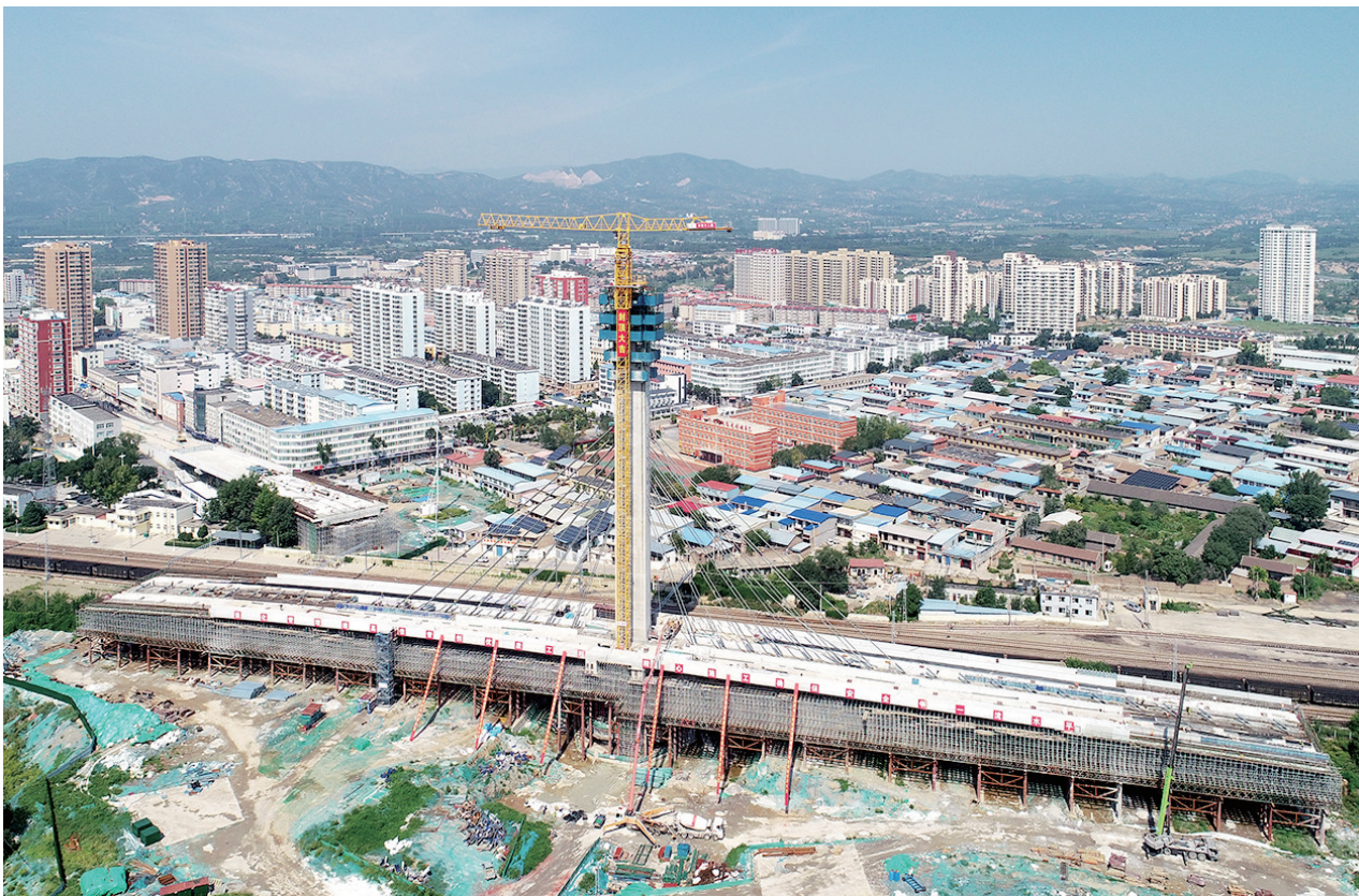
8月30日,由中铁十二局集团承建的阳曲县新阳大街东延项目重要节点——斜拉转体桥主体完工。该桥桥体段长285米、重量3.67万吨,索塔高82.2米,转体对接后将上跨北同蒲铁路,新阳大街也将全线贯通。赵世凯 摄
