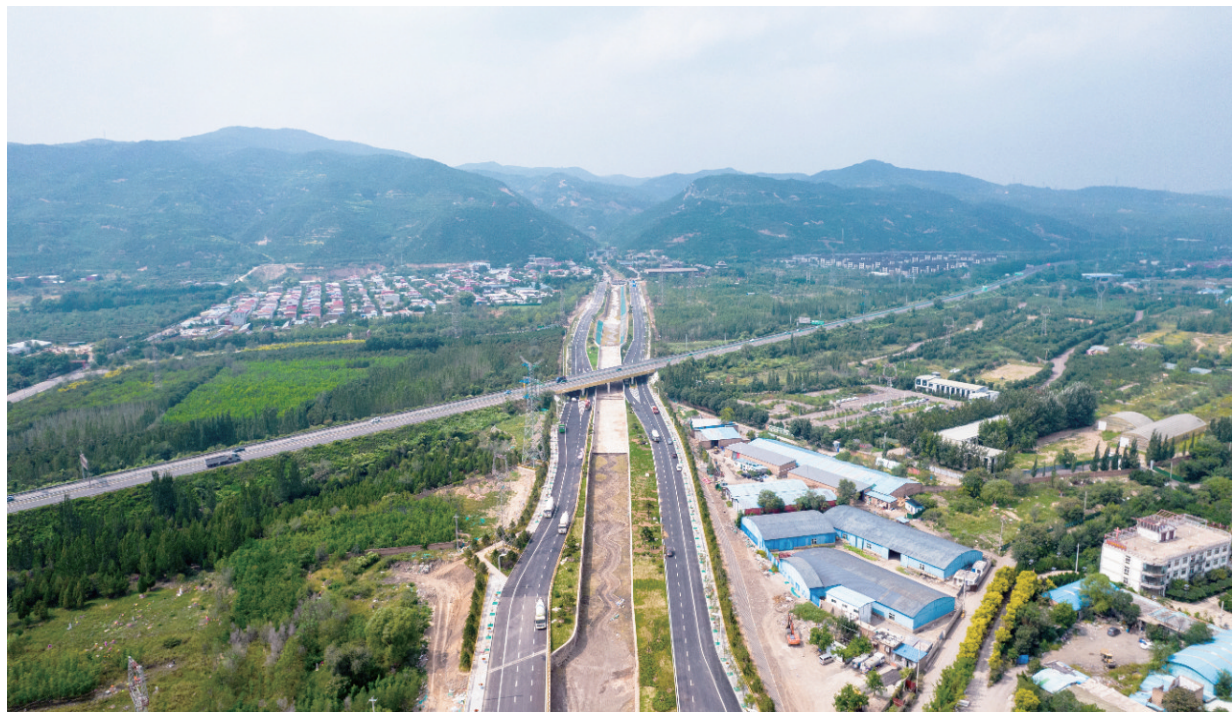
9月8日，进入全面收尾阶段的蒙山大街西延工程，预计9月中旬正式开放通行。工程完工后，从滨河西路到蒙山景区停车场用时不到10分钟，市民出行更加便捷、顺畅。王韵菲 摄
