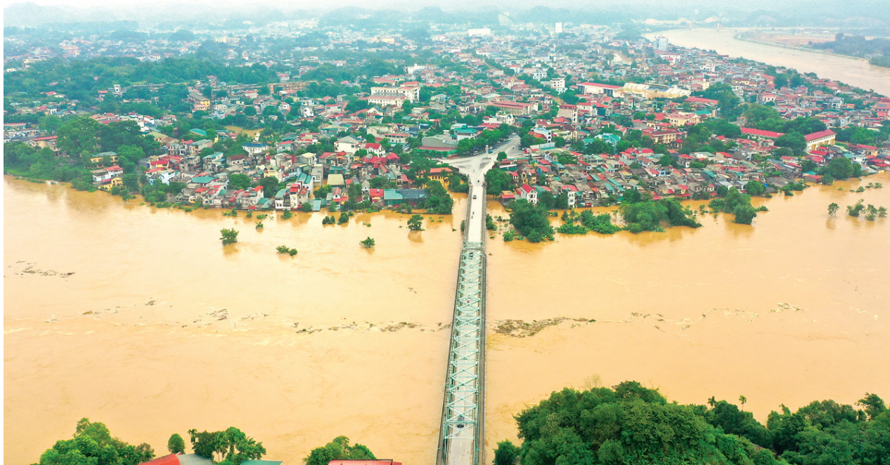
9月9日，在越南北部安沛省，红河水位上涨淹没沿河地区（航拍照片）。据越南农业与农村发展部消息，截至当地时间9日11时30分，台风“摩羯”及其后续影响在越南造成的死亡和失踪人数升至59人。据越通社报道，越南北部富寿省一座钢桥9日上午倒塌。据初步统计，桥梁坍塌时，有10辆汽车和2辆摩托车坠河，已有4人获救，仍有13人失踪。新华社/越通社
