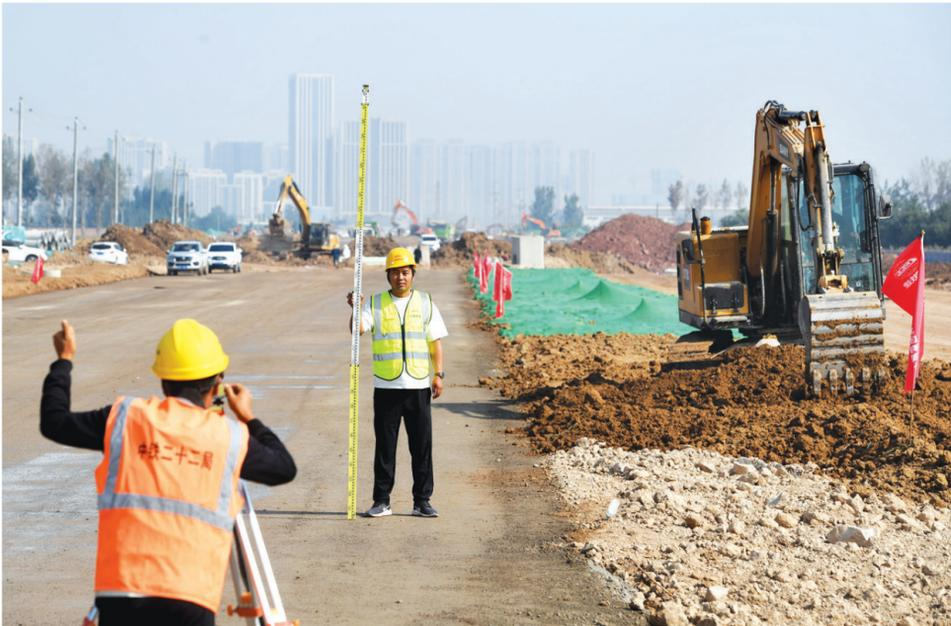
9月24日，由中铁二十二局集团有限公司承建的大运路打通工程施工四标段现场，技术员正在进行路面水稳高程测量。该路段北起汾东大街，南至潇河产业园区北边界辛村街，主线长5.4公里，对于促进推动区域经济高质量发展、加快太原晋中一体化发展具有重大意义。目前已完成道路右侧水稳层摊铺，后续将进行路面沥青层铺设工作。
