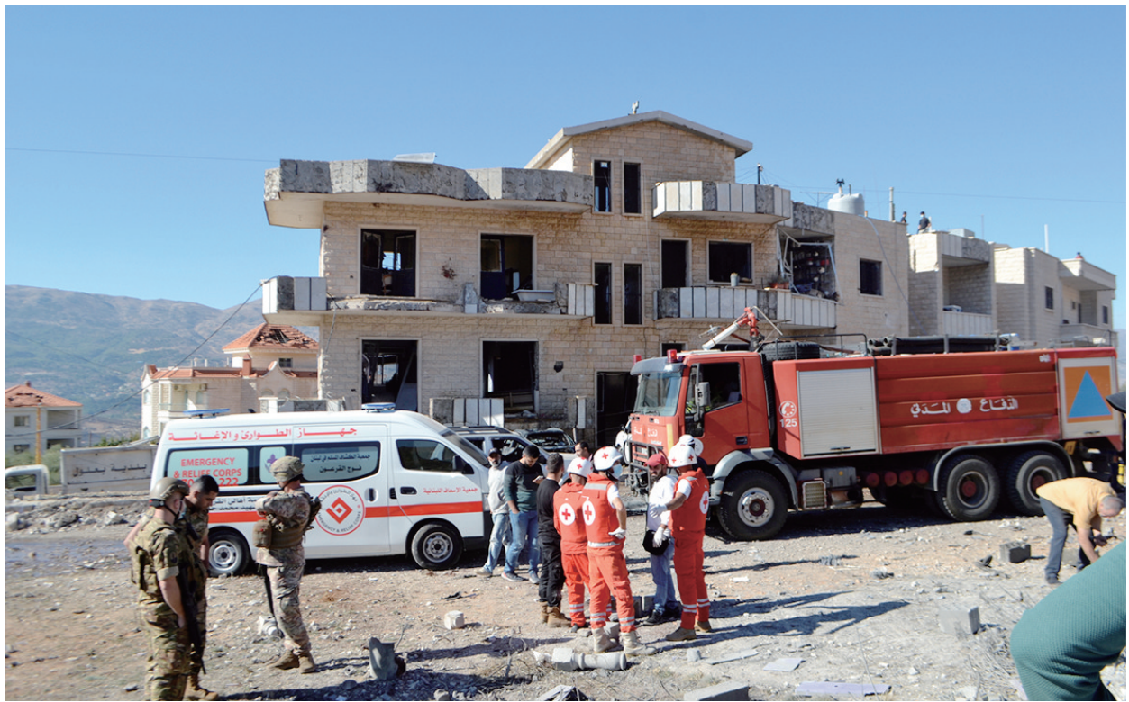
这是10月19日在黎巴嫩巴鲁勒拍摄的被以色列空袭破坏的建筑。新华社发(塔希尔·阿布·哈姆丹 摄)
