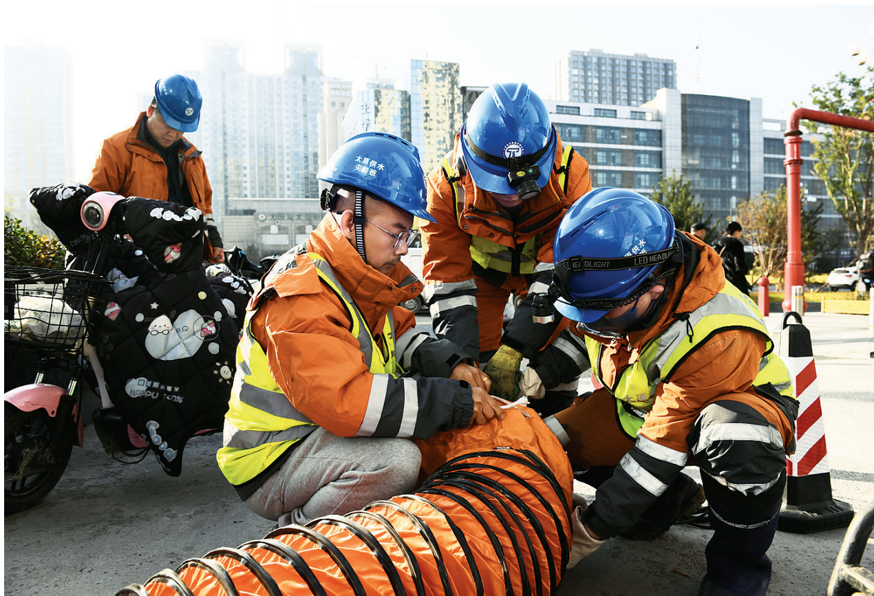
11月25日,太原供水集团城北营销分公司管道队尖刀班的维修人员在迎泽大街万邦国际南水表井外对自来水管进行冬季巡检。寒潮来袭,该公司全力做好排查和整改设施隐患,保障冬季供水安全稳定。牛利敏 摄
