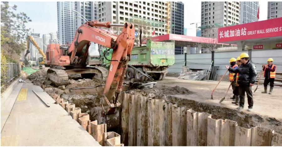
平阳路雨污分流施工现场。
