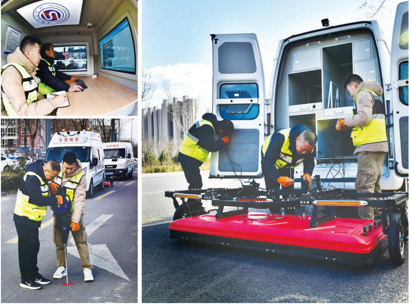
12月10日，市政检测试验站工作人员在利用三维雷达探测车，检测多福路道路空洞，消除安全隐患。今年以来，该站先后对迎泽大街、并州路、府东街等多条道路进行雷达全覆盖探测，全面评估道路隐患分布情况，为道路管理维护提供科学依据。
