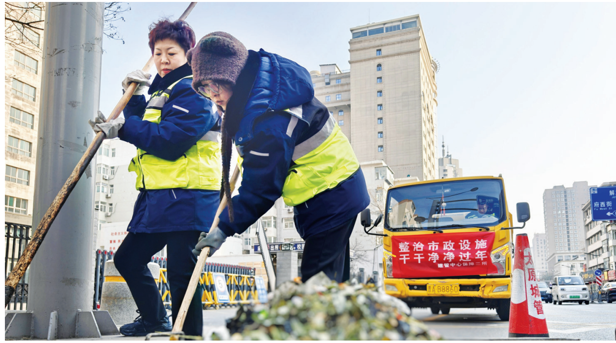
1月23日,太原市政设施建设管理中心保障二所工作人员在水西关街进行进水井清掏工作。临近春节,该所开展集中整治行动,确保市政设施干干净净。 郭苑甫 摄
