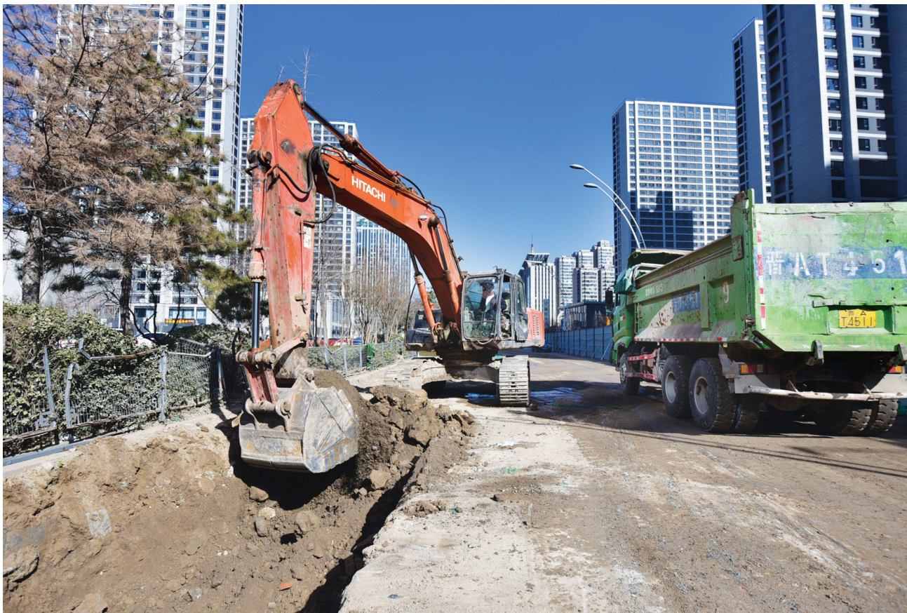
2月20日，平阳路雨污分流改造工程现场，施工人员正在操控大型机械挖掘路面。目前，市政建管中心承担的雨污分流及混接节点改造项目全面复工复产，奋力夺取重点工程建设“开门红”。牛利敏 杨斌 摄影报道
