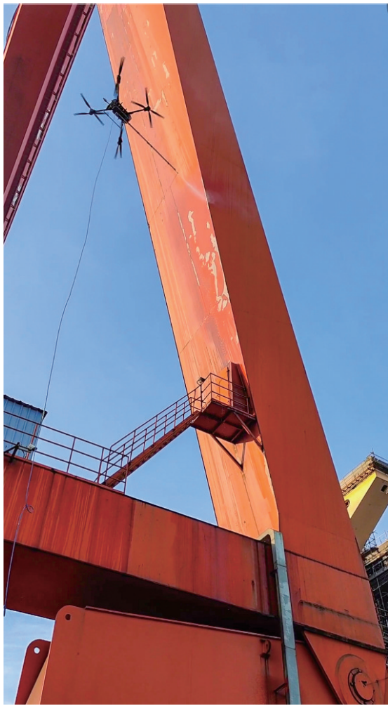
龙门吊除锈喷漆作业
