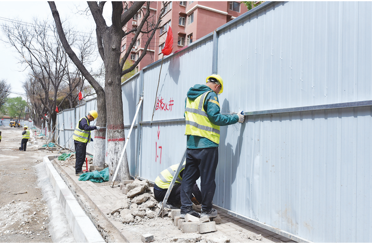
4月11日，太原市市政建管中心对工地围挡进行加固，以应对极端大风天气。
