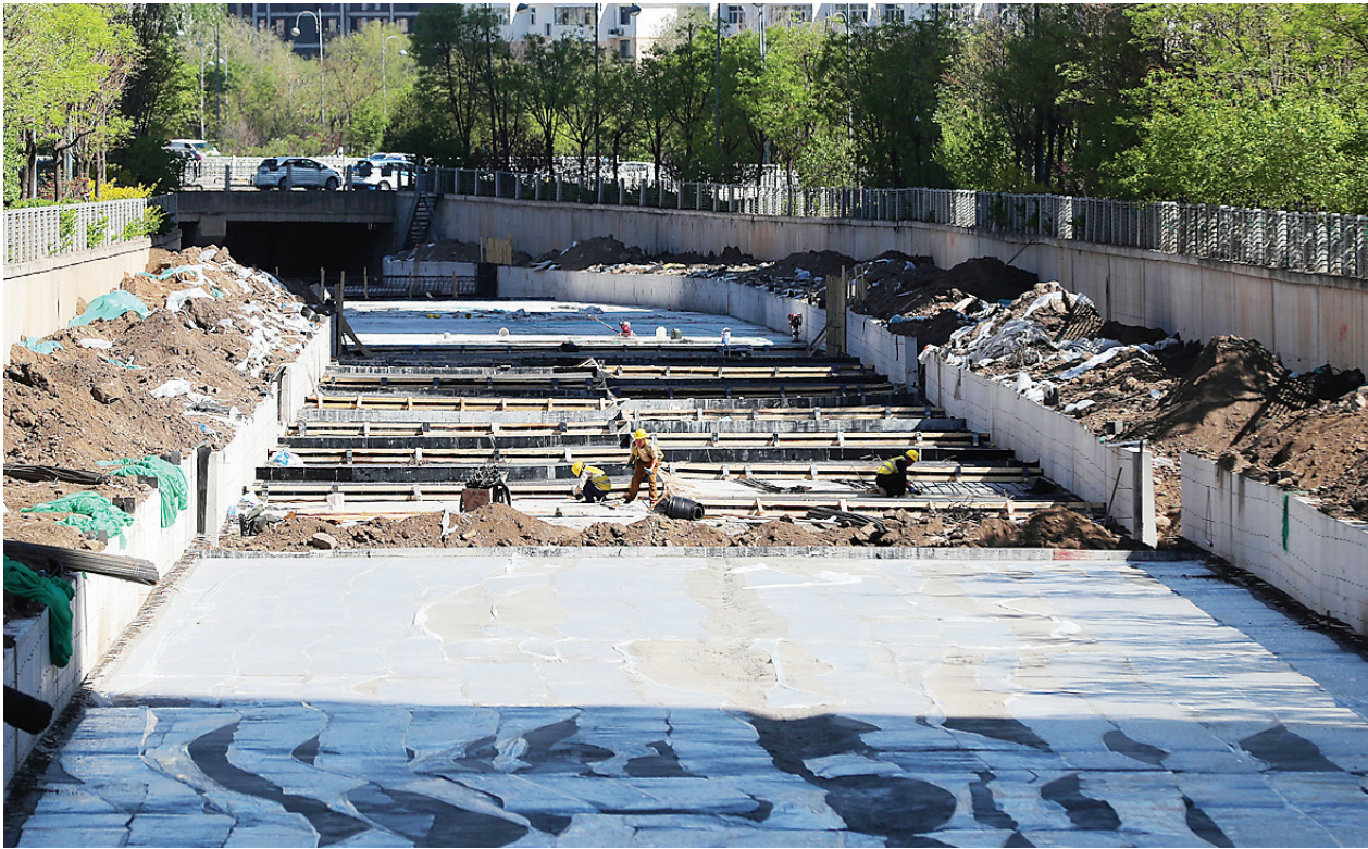
4月24日,万柏林区九院沙河生态复流工程施工现场,施工人员进行配套设施施工。该工程包括河道清淤疏浚和新建沉砂池、主槽、挡水堰等。建成后,将推动防洪工程体系建设、河湖生态环境治理等方面迈上新台阶。王韵菲 摄
