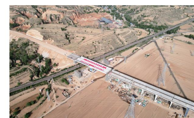
图为国道108线改建工程小泉沟特大桥顺时针转动76°后与主线桥实现完美衔接。
