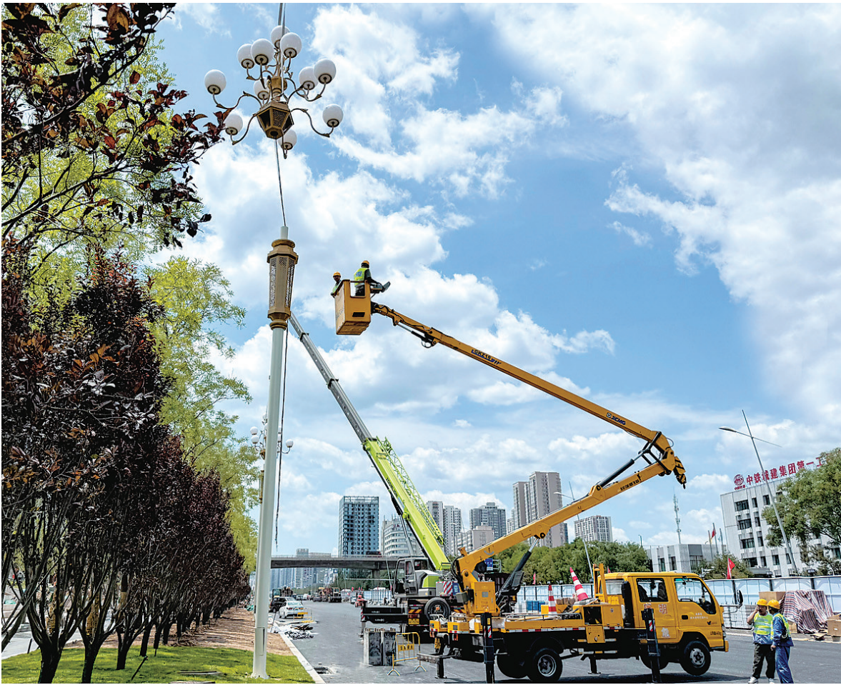
6月17日,迎泽大街(西段)改造工程现场,施工人员对路灯进行了安装调试,全力保障工程有序推进。 牛利敏 摄
