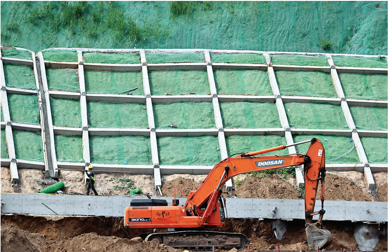
6月29日,万柏林区新建白家庄回迁安置房城中村改造项目边坡治理工程正在紧张施工。完工后,将有效消除边坡临近住宅的安全隐患。
