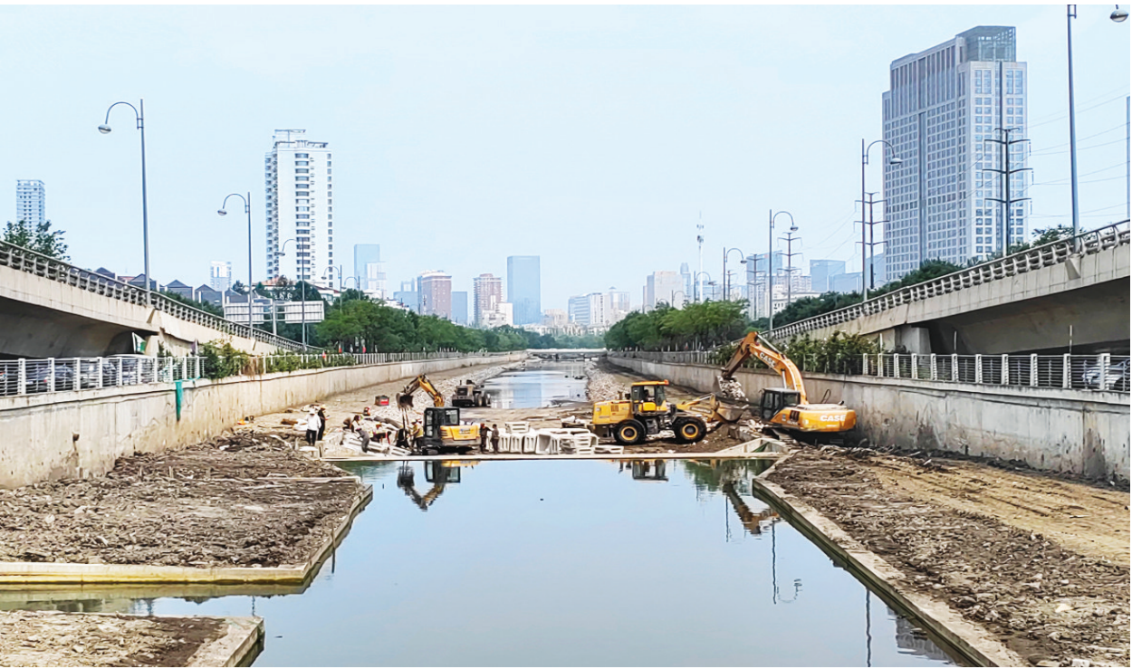
7月13日,万柏林区九院沙河复流工程接近尾声。该治理段西起万亩生态园,东至入汾口,总长8.18公里。目前,已完成主河槽工程6000余米、挡水堰11座、沉砂池1座、出水口5座、生态堰安装约1900米。
