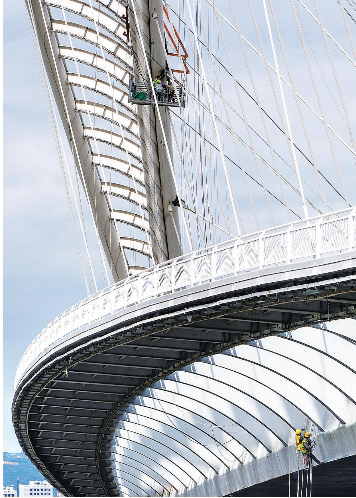
8月18日,南中环桥上耳板斜拉索更换维修工程有序推进中。截至目前,南中环桥养护工程完成量已达80%。
