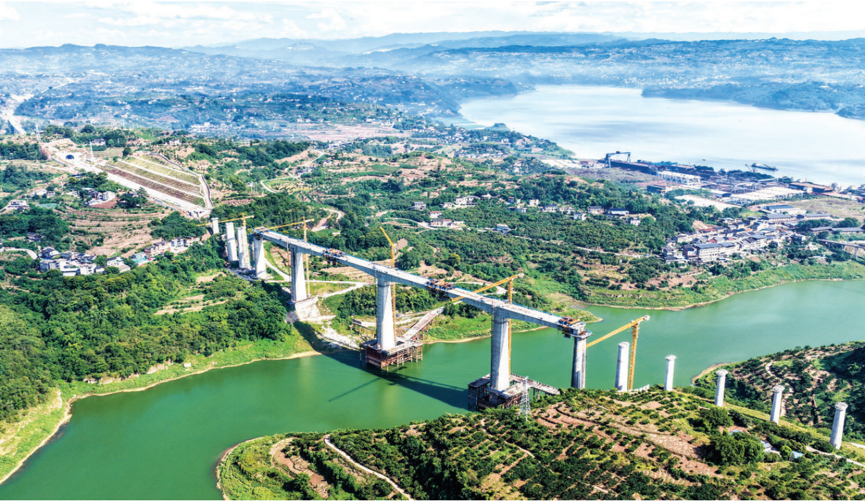
这是8月18日拍摄的渝万高铁渠溪河双线特大桥施工现场（无人机照片）。当日，由中国铁建大桥局承建的重庆至万州高速铁路（渝万高铁）渠溪河双线特大桥顺利合龙。渝万高铁渠溪河双线特大桥位于重庆市涪陵区珍溪镇，横跨长江支流渠溪河，全长约953米，是全线重难点工程。 新华社记者 唐奕 摄
