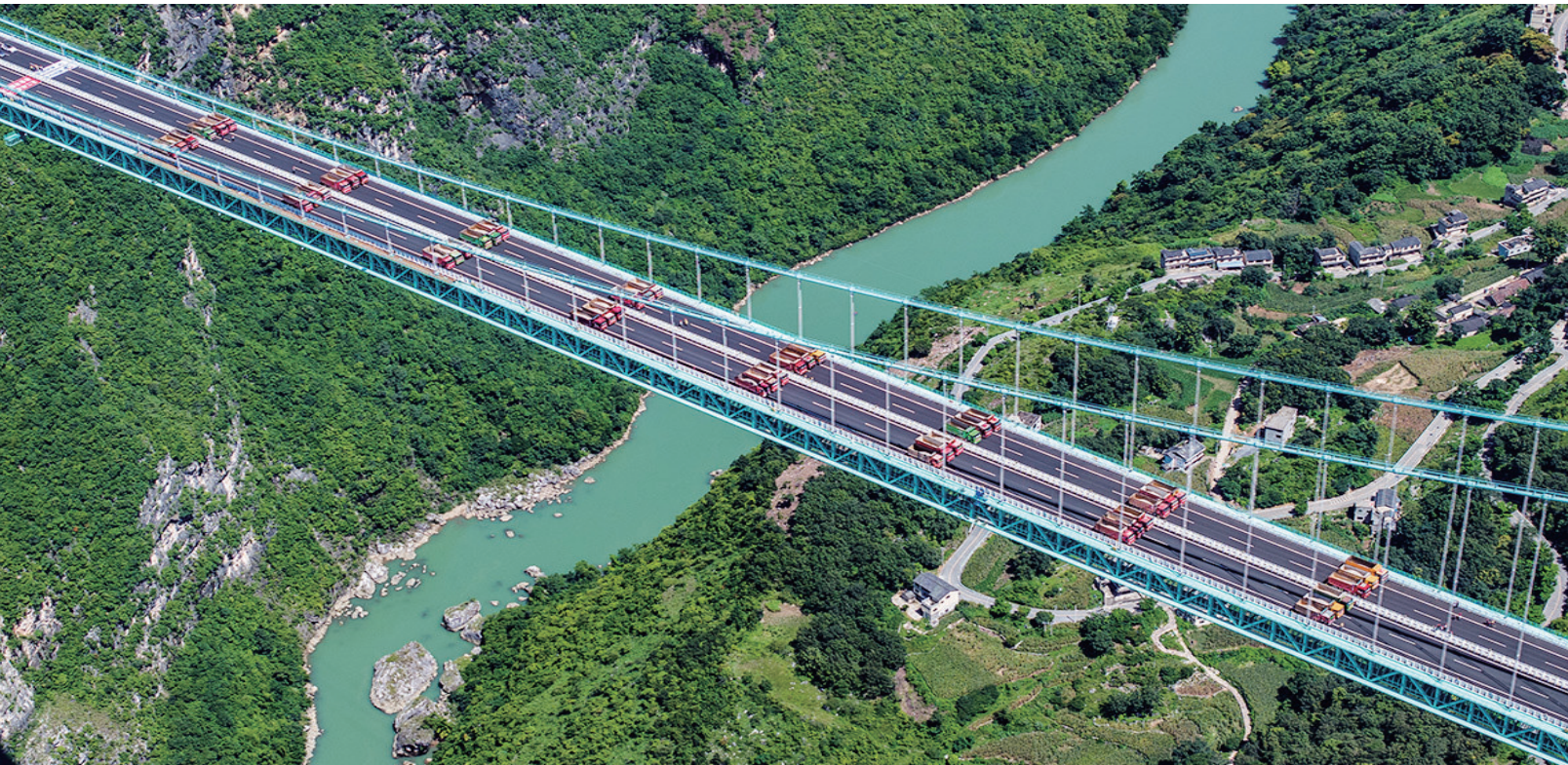
8月25日拍摄的贵州花江峡谷大桥荷载试验现场(无人机照片)。 8月25日,在建世界第一高桥——贵州花江峡谷大桥荷载试验顺利完成,通车在即。 花江峡谷大桥于2022年1月开工建设,是贵州六枝至安龙高速公路的控制性工程,全长2890米,主桥跨径1420米,桥面到水面高度625米。花江峡谷大桥建成后,主桥跨径将居山区桥梁跨径世界第一、桥梁高度将居世界第一。 新华社记者 陶 亮 摄
