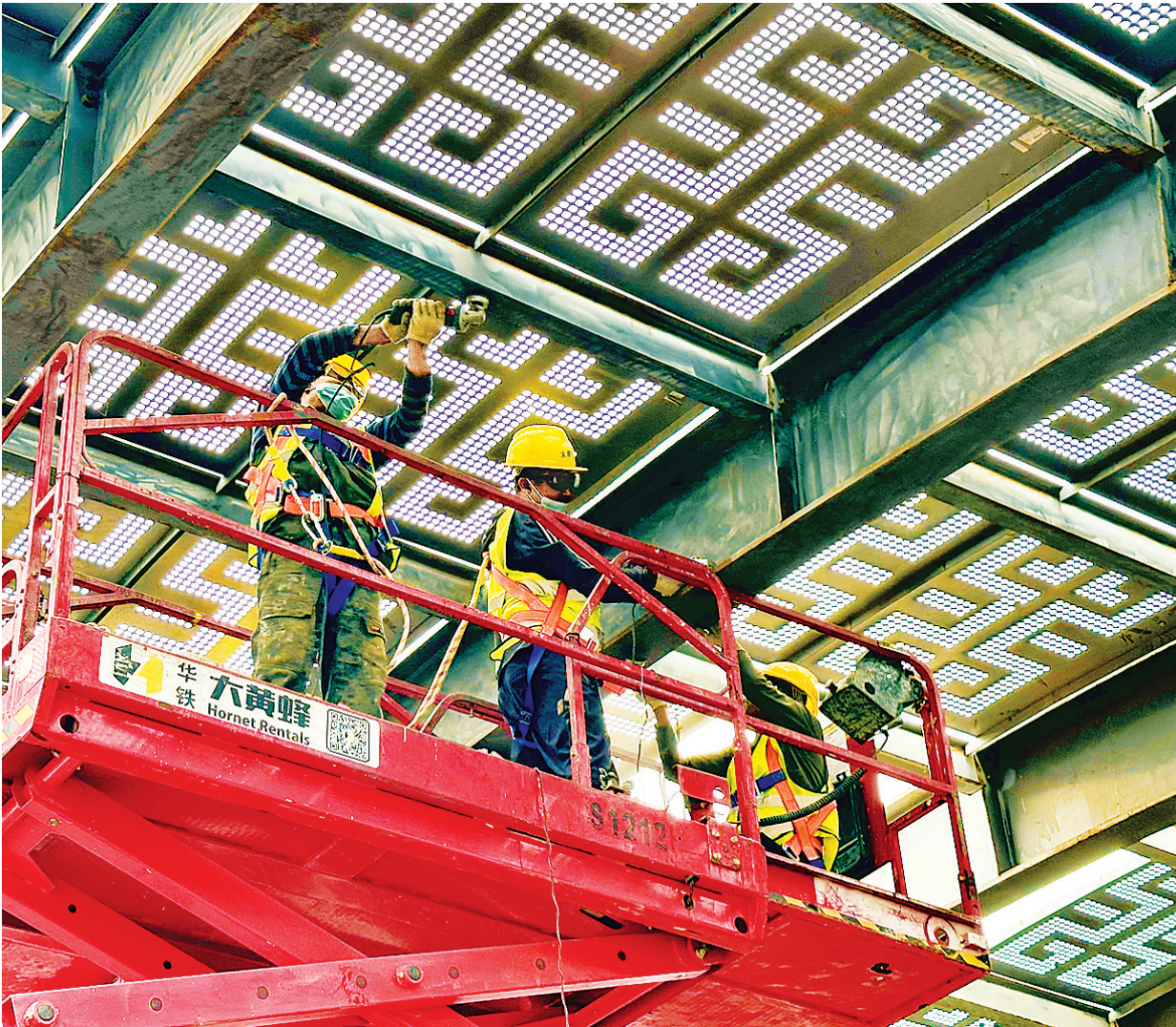
9月13日,施工人员在晋阳大道下穿通道内开展养护作业。因晋阳大道迎宾路、晋阳湖地下通道的多处变形缝存在渗水现象,每到冬季渗水处会结冰,给过往车辆通行带来安全风险。市政部门此次针对这两处通道开展专项养护,系统解决变形缝渗水问题,消除冬季结冰隐患。
