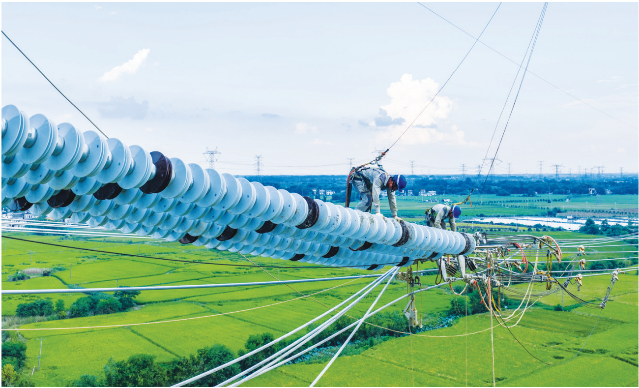
在安徽省芜湖市南陵县，安徽送变电工程有限公司施工人员在高空进行架线施工（9月16日摄，无人机照片）。近日，甘肃至浙江±800千伏特高压直流输电工程安徽段进入架线施工阶段。据悉，甘浙特高压工程是国家“十四五”电力发展规划重点项目，起于甘肃省武威市，止于浙江省绍兴市，全长约2370千米；投运后将有效促进西部“沙戈荒”大基地清洁能源外送，缓解华东地区电力供需矛盾，每年可向浙江输送电量超360亿千瓦时。新华社发（郑贤烈 摄）
