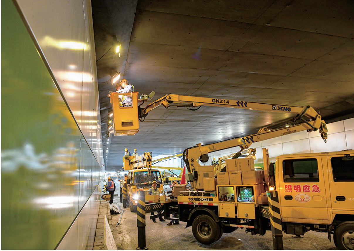
9月18日，晋阳大道下穿通道照明设施改造正有序推进。
