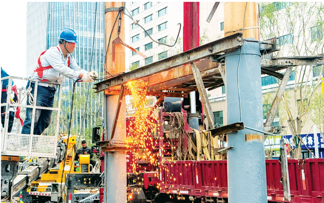
自九月十六日起，新建路改造工程正式启动。架空线缆入地作业，实现所有线缆地下敷设。九月十九日，施工人员进行道路两侧电线杆及空中线缆设施拆除。 牛利敏 摄
