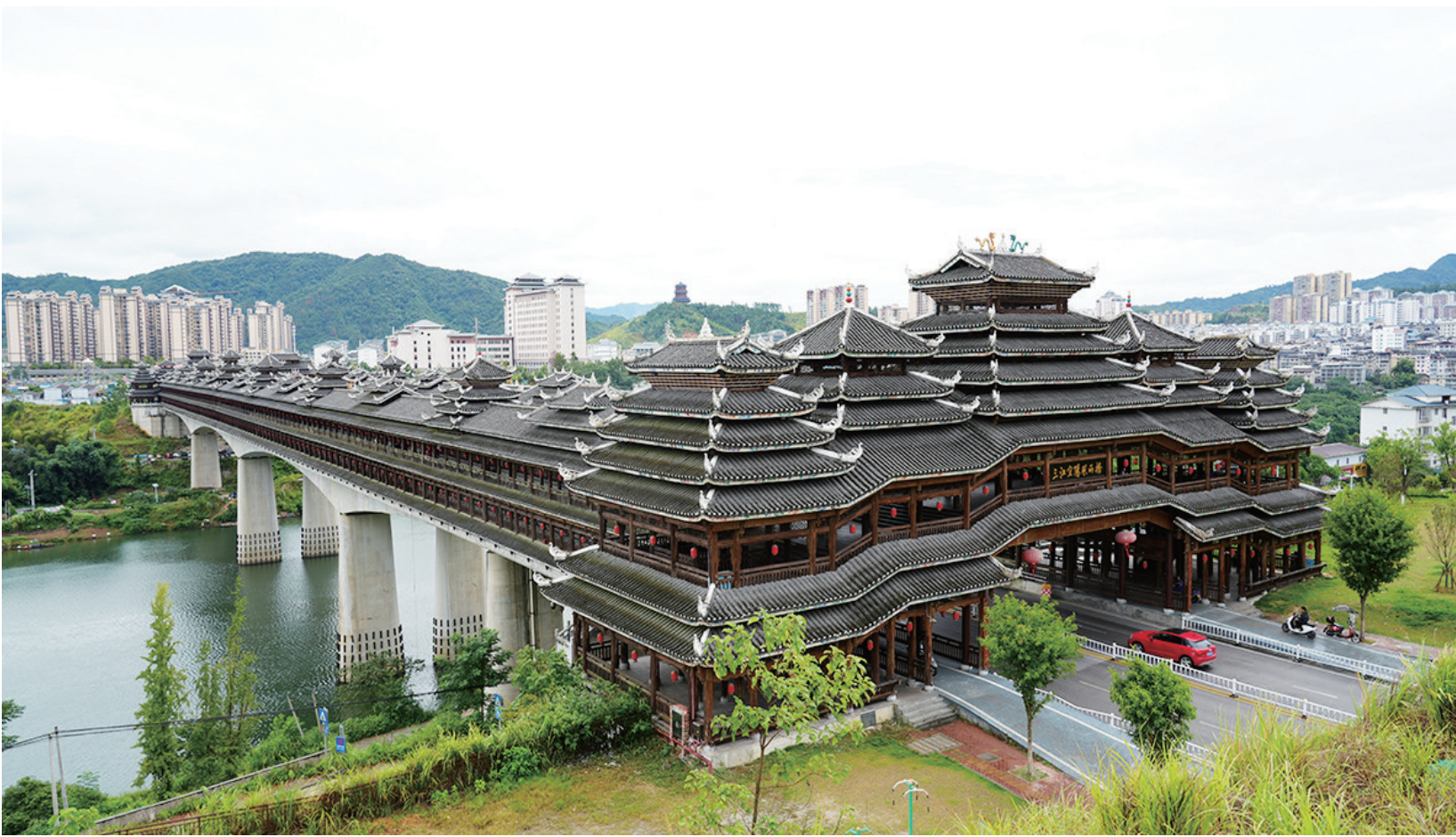
这是9月25日拍摄的三江侗族自治县的宜阳风雨桥。该桥横跨浔江之上,全长399.6米,宽28米。桥面设双向四车道,桥上共两层,二层建有跨桥人行通道。侗族木构建筑营造技艺于2006年被列入国家级非物质文化遗产代表性项目名录。侗族木构建筑穿梁接拱、立柱连枋大量使用榫卯结构,牢固缜密,具有极高的工艺和艺术价值。 新华社记者 张枫 摄
