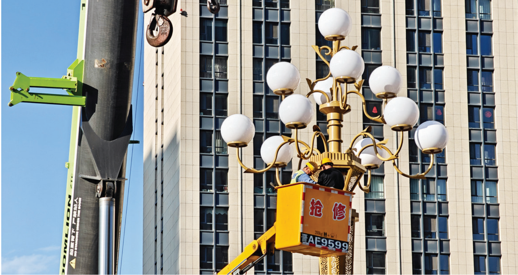
10月13日,新建路改造工程施工现场,工人在安装路灯。此次安装的路灯采用中华灯灯型,照明层次更加丰富,光源全部为节能、低碳、智能的LED。 郭苑甫 摄
