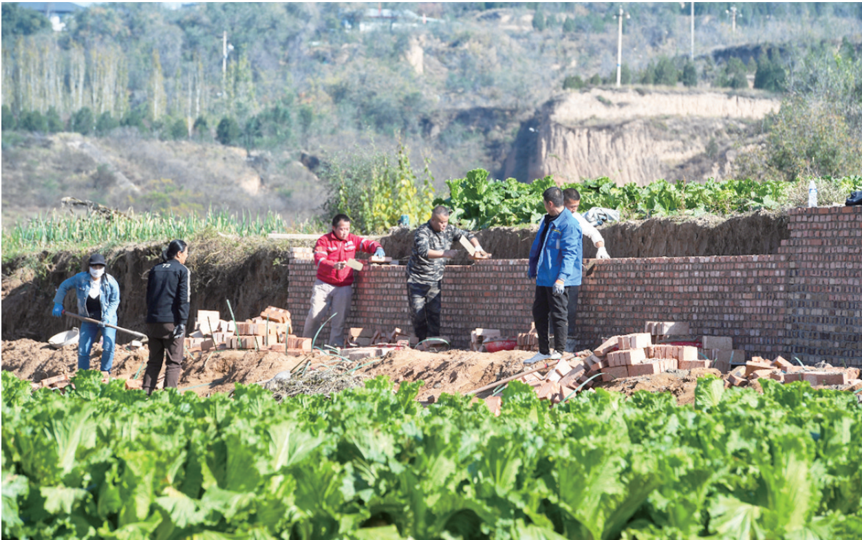
10月31日，杏花岭区中涧河镇耿家庄村北梁的田间地头，施工人员正忙碌着砌筑挡墙、整修水渠。本次工程将对该村80余亩耕地周边的灌溉水渠、田埂、排水系统和护坡等基础设施进行全面维修改造，以改善农田的灌溉条件和防洪排水能力。
