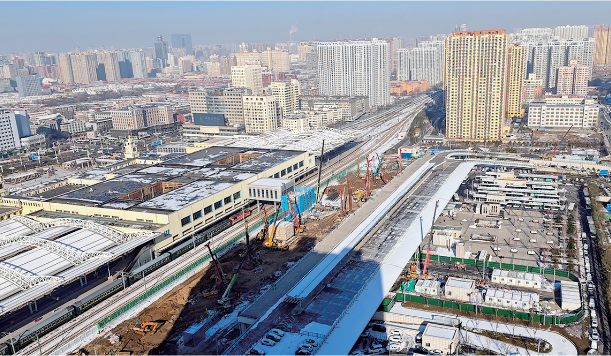
12月15日,太原站新建东 station 房工程有序推进。东 station 房位于太原站东广场西侧,由站房、换电站、站台南棚组成。建成后,它将成为集普速、高铁、地铁、公交于一体的现代化综合枢纽。
